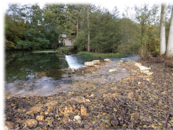
Après travaux, brèche aménagée (Clain, nov. 21)
