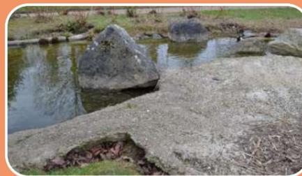
Des berges en béton incompatibles avec le développement de végétations
