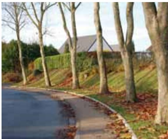
À la demande des riverains, un trottoir d'accès aux résidences "Dachevin" et de "la Lanquette" vient d'être réalisé. Le revêtement utilisé, léger, permet l'infiltration des eaux pluviales.
