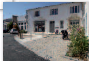
Placette Chay Morin après travaux
