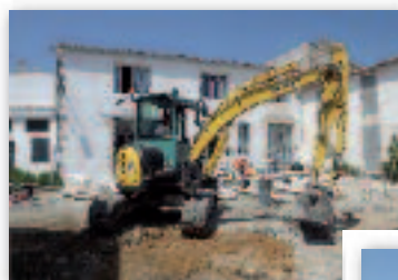
Placette Chay Morin en travaux
