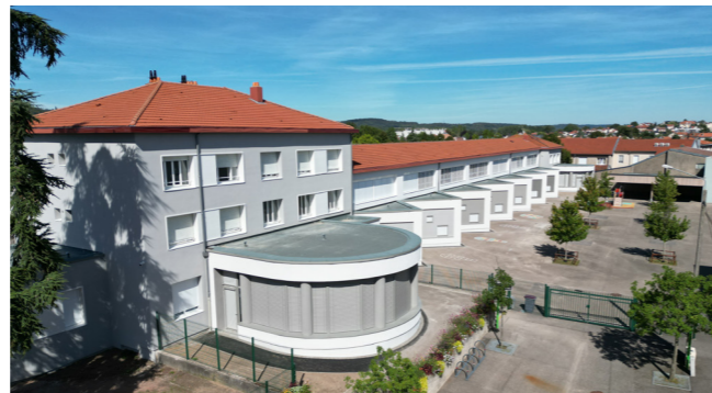
Rénovation de l'école - Maurice Carême
