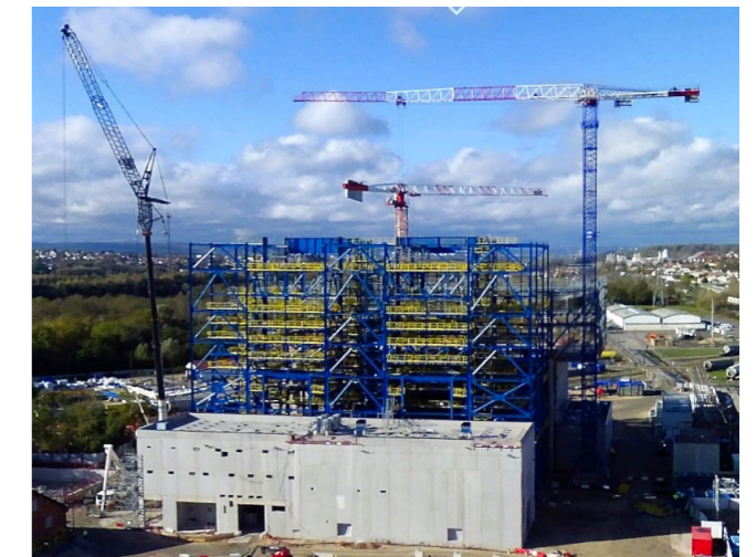
Chantier Dombasle Énergie - Chaufferie CSR en partenariat avec Véolia
