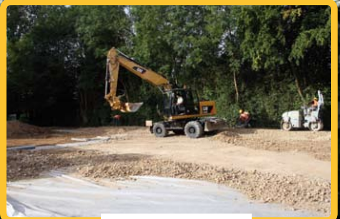
travaux Allée M.Goré
