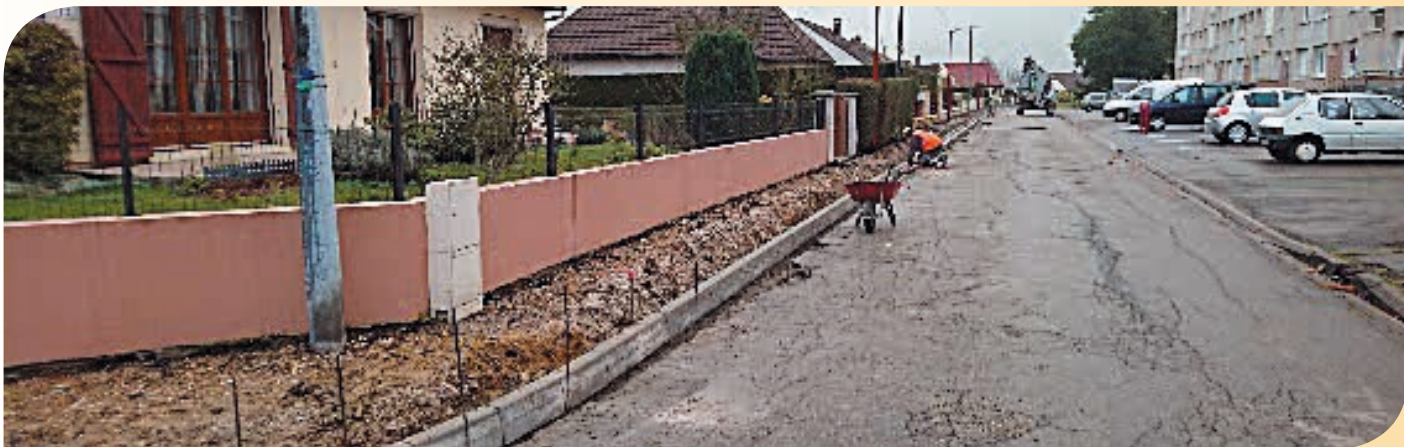
Réfection des trottoirs rue des Primevères
