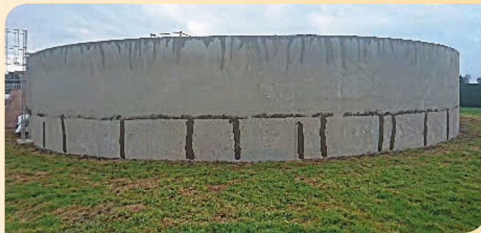
Traitement des fissures
