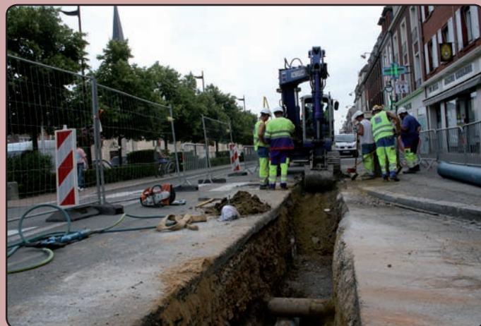
Travaux du Syndicat des Eaux
