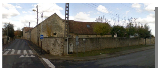
Ferme (rue Aristide Briand)
