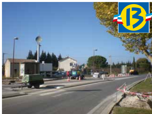
Mise en accessibilité de l'abribus de la Clastre réalisée par le Conseil Général
