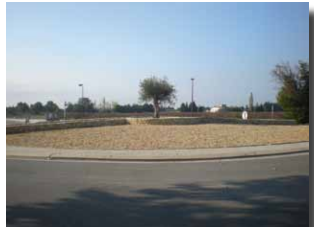
Aménagement du rond-point de la Clastre réalisé par les services techniques
