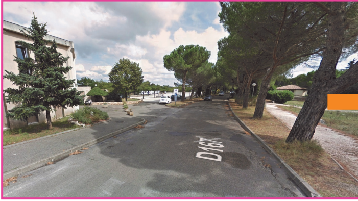
Route dangereuse due aux racines des pins pignons (coupés en février 2015)
