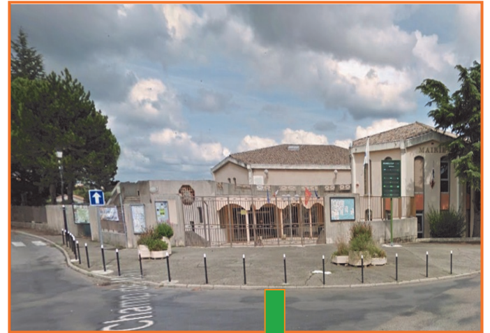
La mairie avant les travaux
