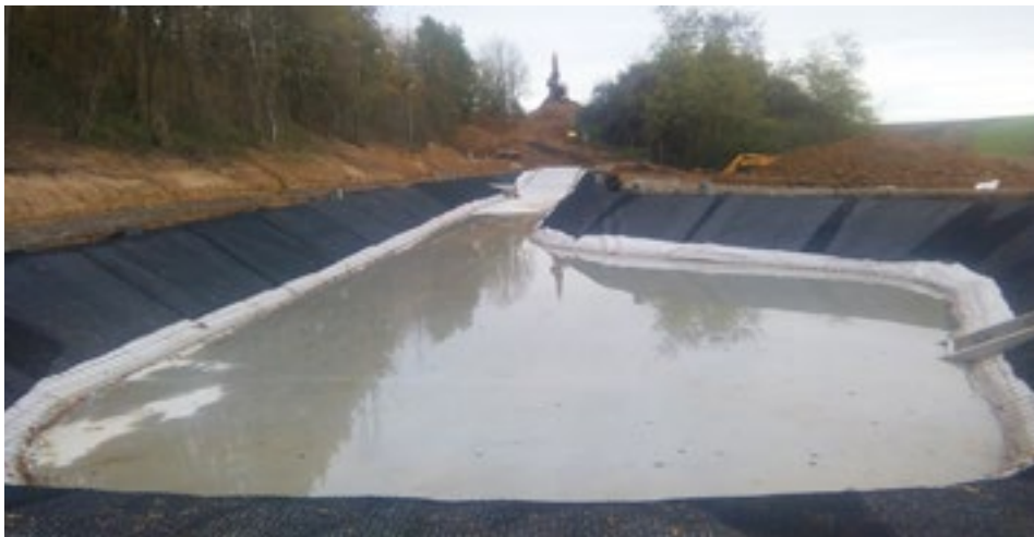
Bassin de rétention côté Rissbach
