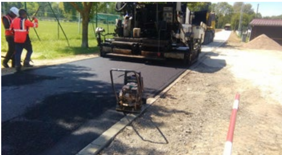
Pose d'enrobé sur chemin d'exploitation
