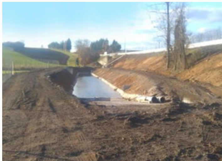
Bassin de rétention Minversheimerbach
