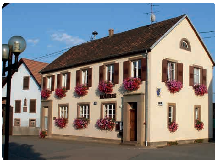
La salle socio-éducative - MAIRIE 12 rue de l'école - Schaffhouse-sur-Zorn 67270 HOCHFELDEN
