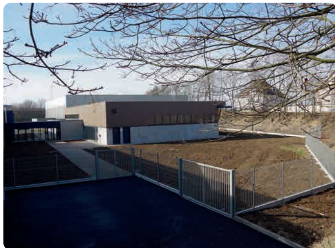
La salle de danse rue des quatre vents - 67270 HOCHFELDEN
