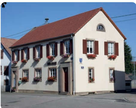
Refection toiture mairie
