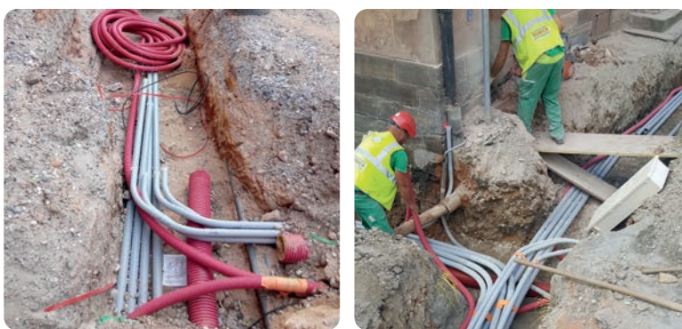
Enfouissement de réseaux secs
