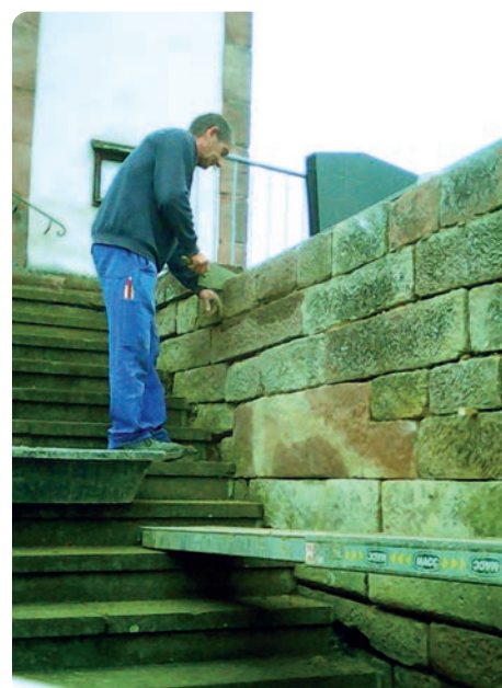
Travaux de maçonnerie du mur du cimetière
