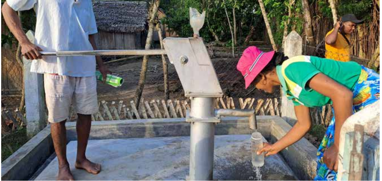
Forage équipé d'une pompe à motricité humaine (Madagascar).
