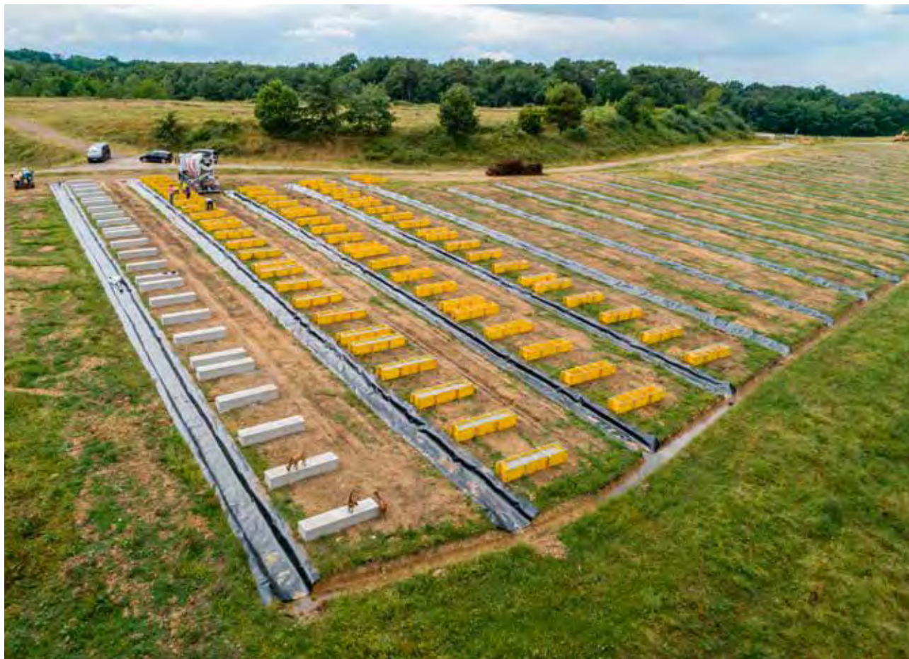
Centrale solaire photovoltaïque en cours de construction
