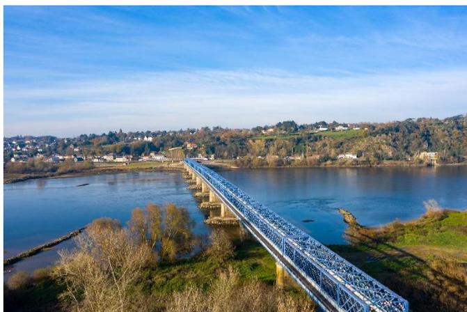
Ces deux ouvrages sont des **ponts métalliques de type « pont cage »**, une structure qui limite leur niveau de service en termes de gabarit et de résistance.
