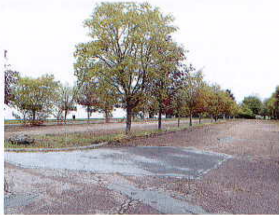
Alignements d'arbres non conservés
