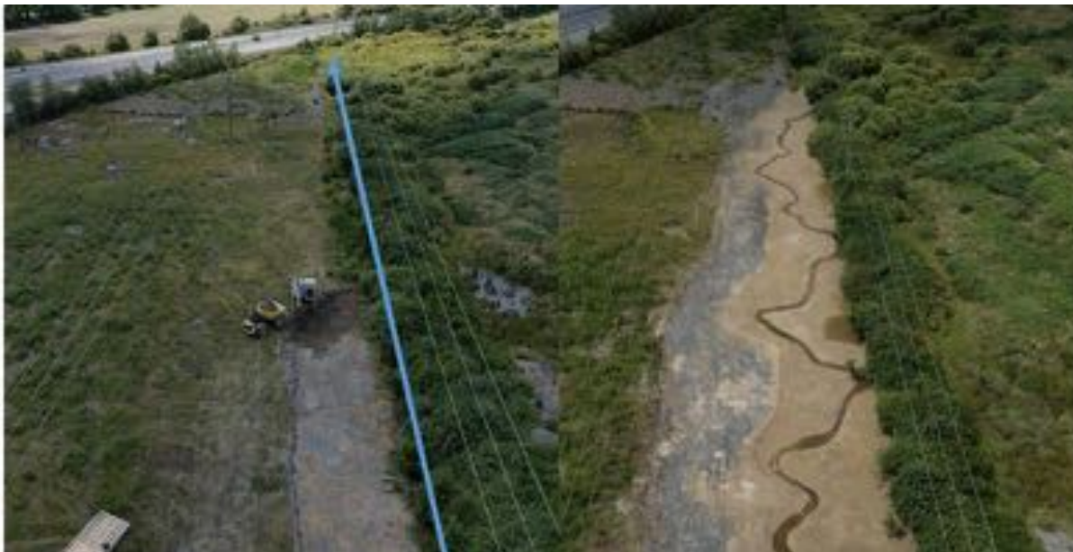
Figure 5 : Renaturation du Pas d'Hin : avant/après la recréation d'un lit sinueux (Source : SCDI)
