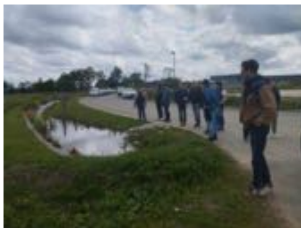
Figure 12 : Gestion alternative des eaux pluviales / noue (Source : ATBVB)
