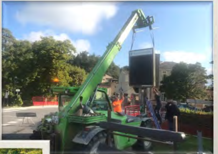
Installation d'un panneau lumineux
