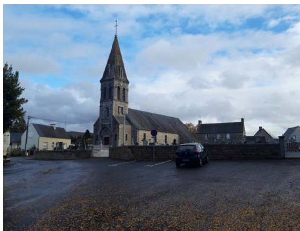
De vastes espaces publics imperméabilisés
