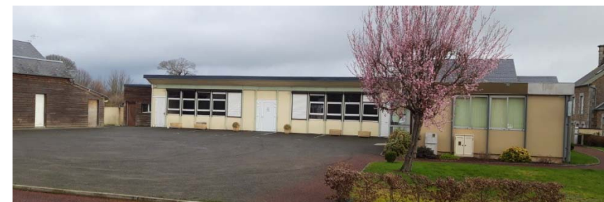
Une salle des fêtes architecturalement peu qualitative, sera bardée dans le cadre des travaux de rénovation
