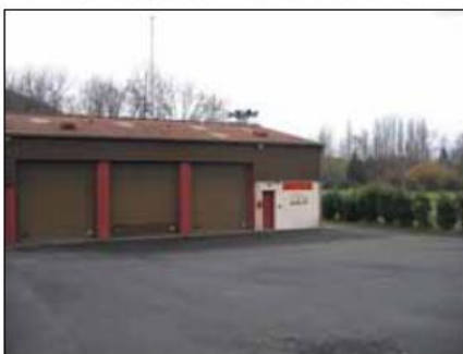
Photo 9 : caserne des pompiers en zone inondable
