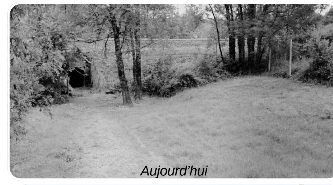
Amélioration du passage sous-voie (boviduc)
