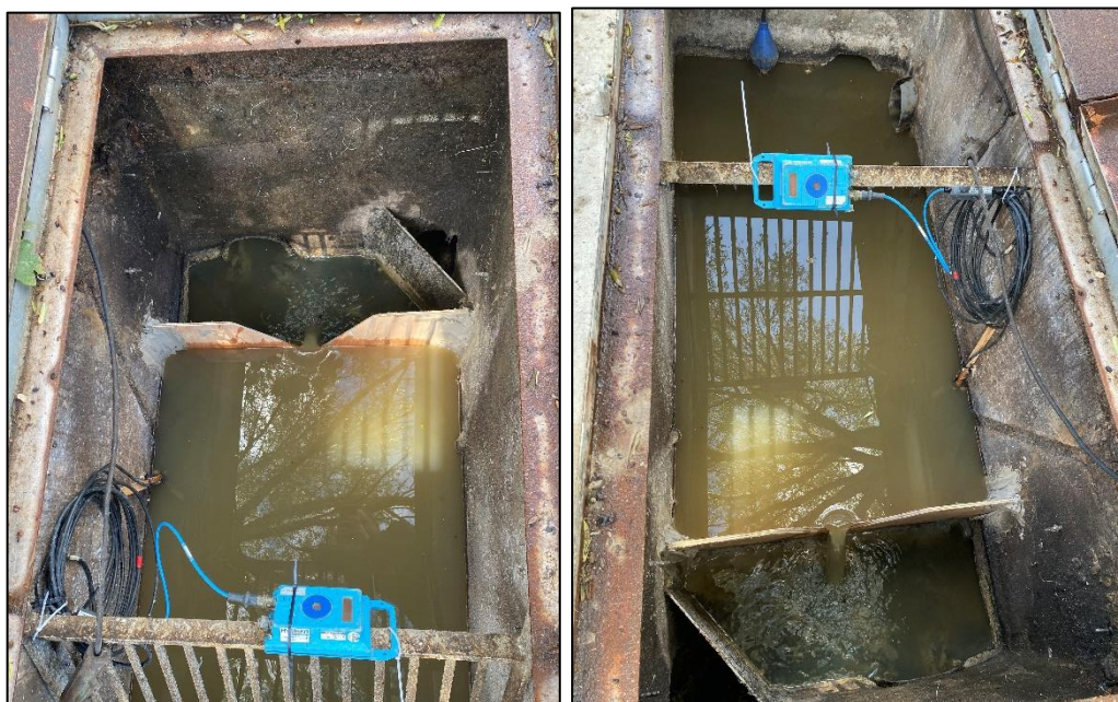
Figure 21 : Photographies du seuil déversoir lors des mesures de novembre 2022
