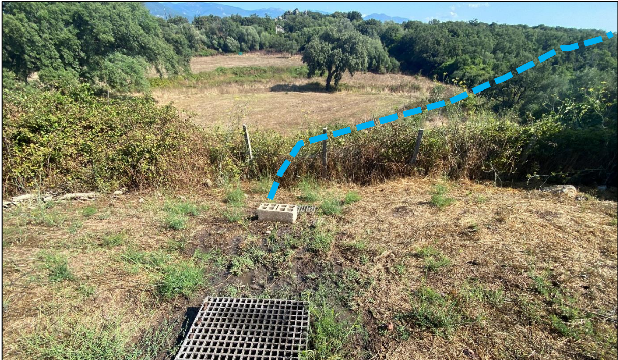
Figure 32 : Exutoire actuel de la station de traitement des eaux usées de la commune de Sotta
