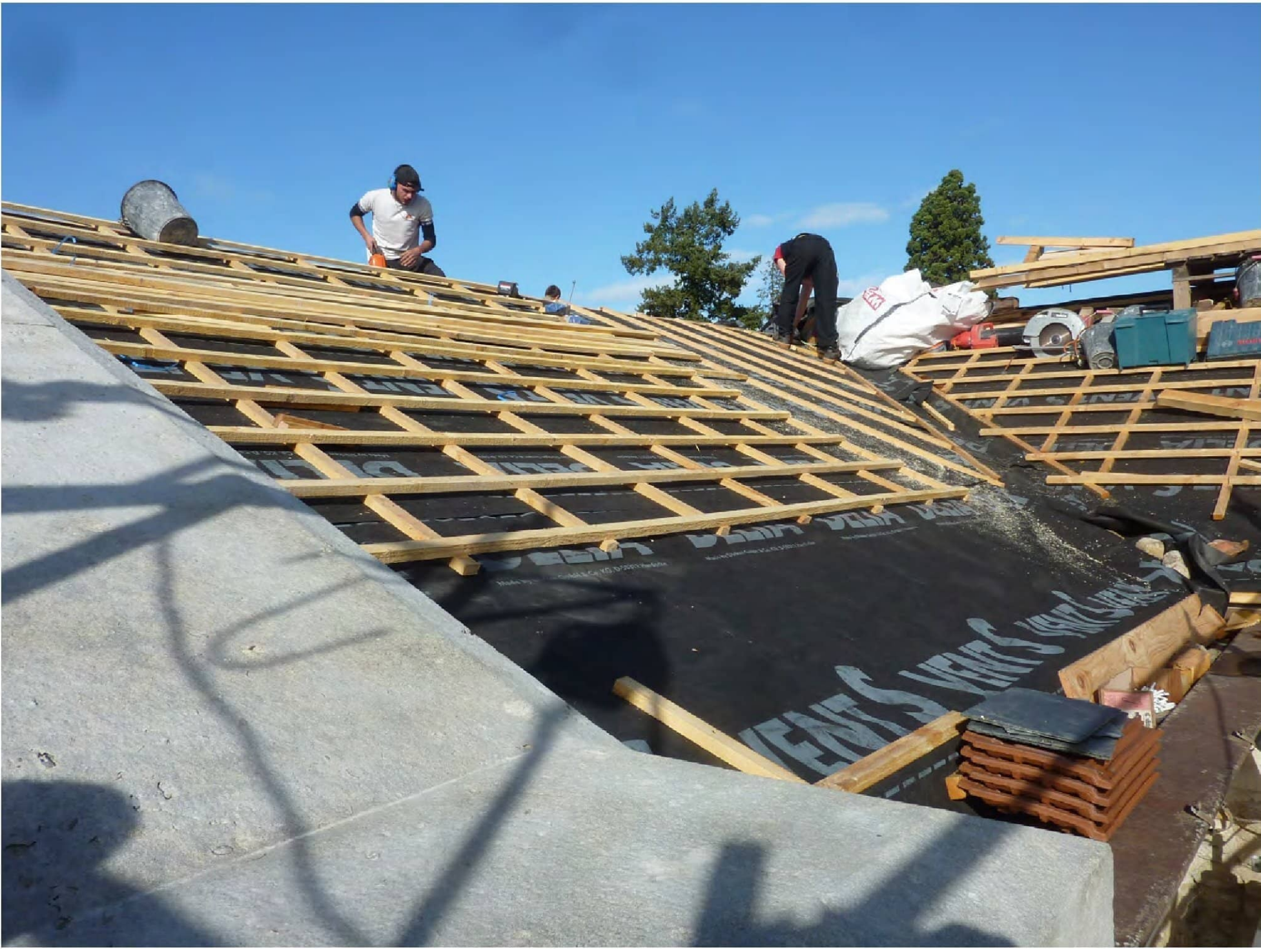
Par dessus la volige est ici mis en place le film de sous-toiture, qui permet de protéger de la pluie en cas de bris d'une tuile, et fixé par deux rangées de liteaux croisées.
