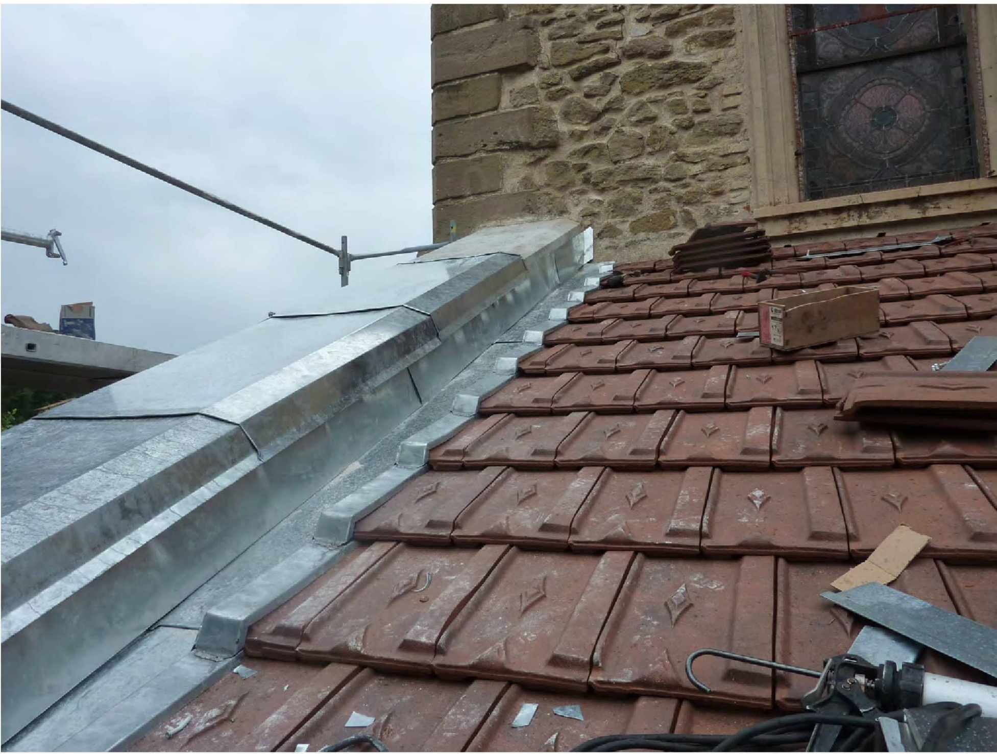
Les couvertines en pierre qui bordent toutes les toitures, très fragilisées, ont été protégées par un habillage en zinc naturel pour assurer leur pérennité dans le temps.
