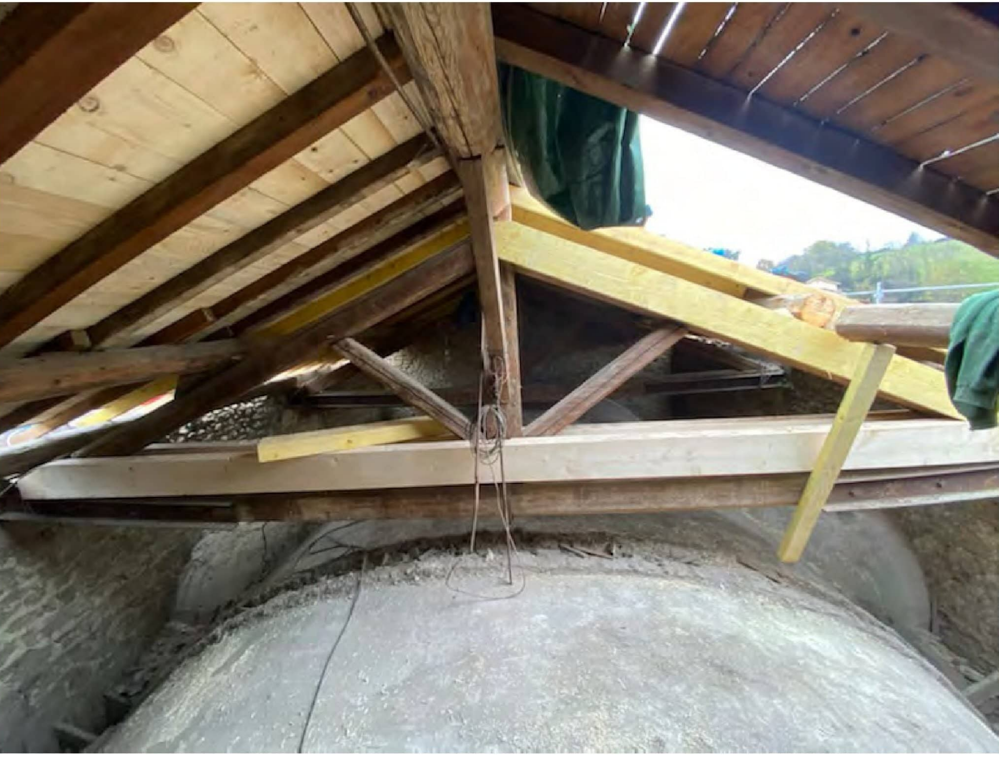
Les charpentes existantes ont été au maximum conservées et restaurées. Il a été privilégié des renforts par doublage. Quelques pièces, trop altérées, ont dû être remplacées à neuf.
