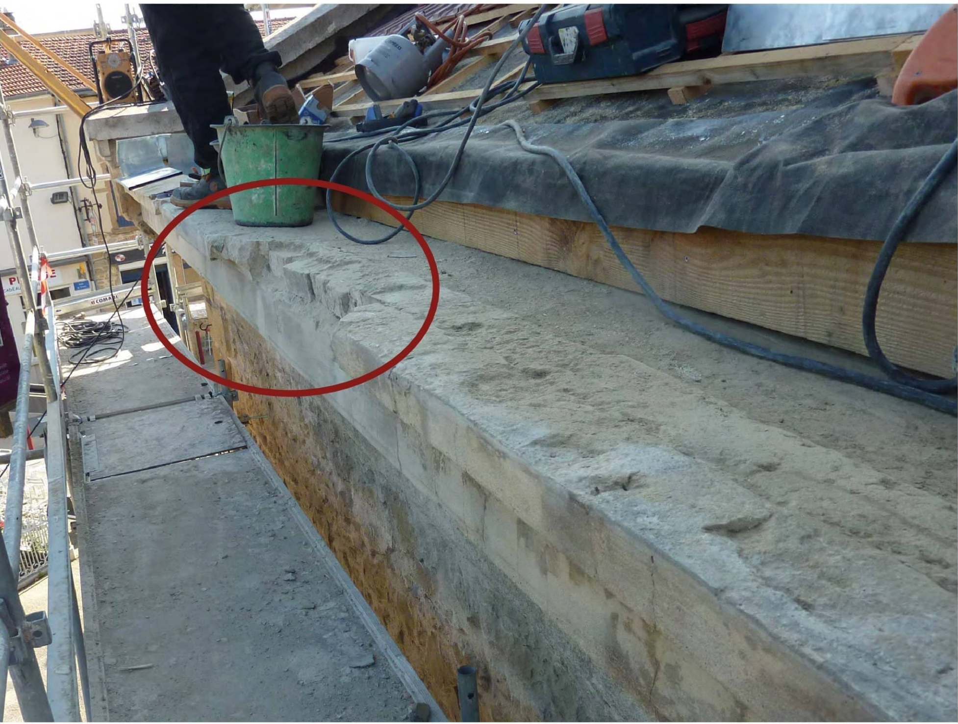
Les corniches en ciment moulé ont également souffert dans le temps des fuites des chéneaux. Plusieurs sections ont dû être reconstituées au ciment prompt naturel.
