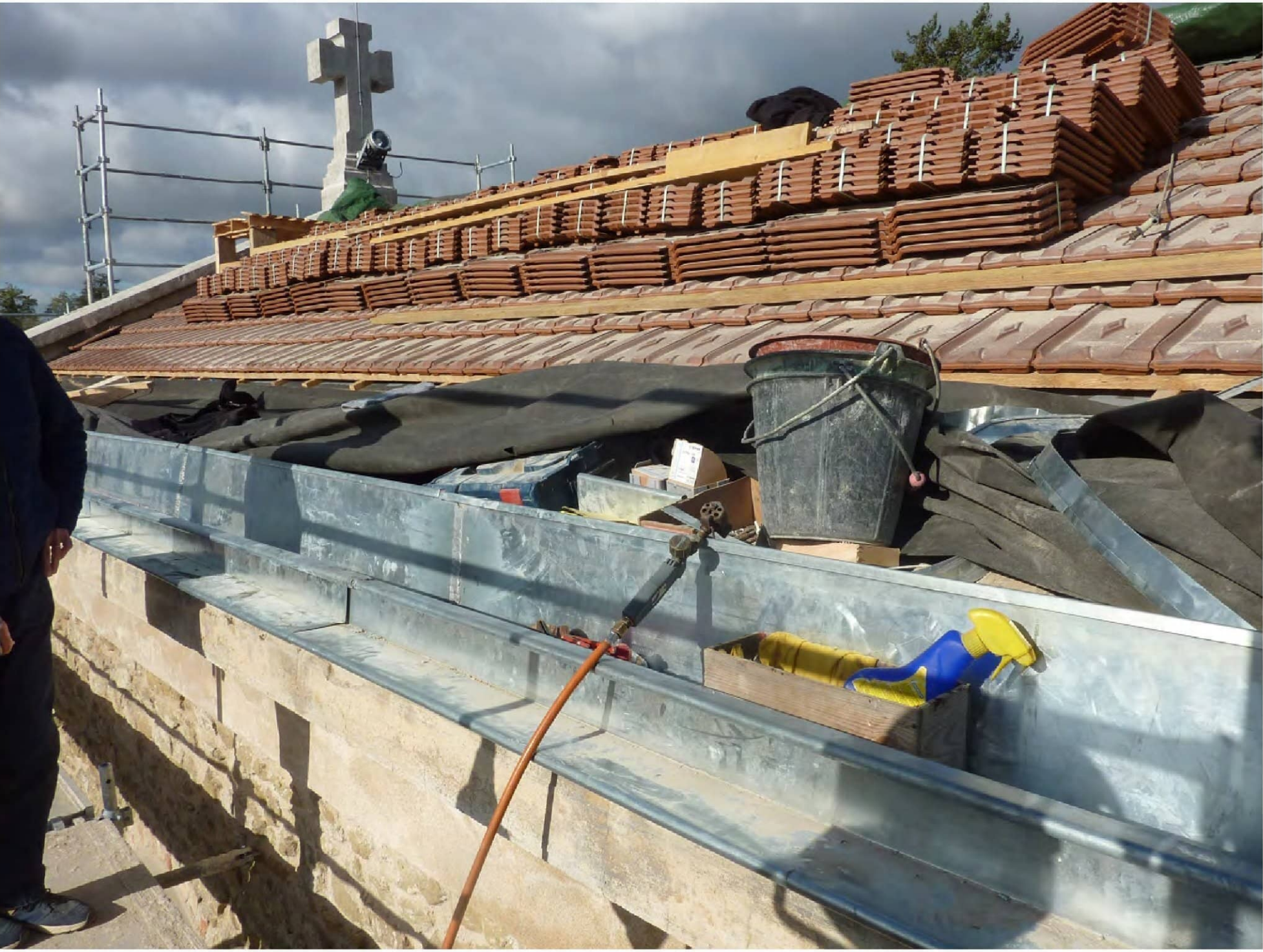
Les chéneaux en zinc de bas de pente ont tous été entièrement refaits à neuf, avec un profil plus profond pour être en capacité de récolter les volumes d'eau des pluies les plus importantes.
