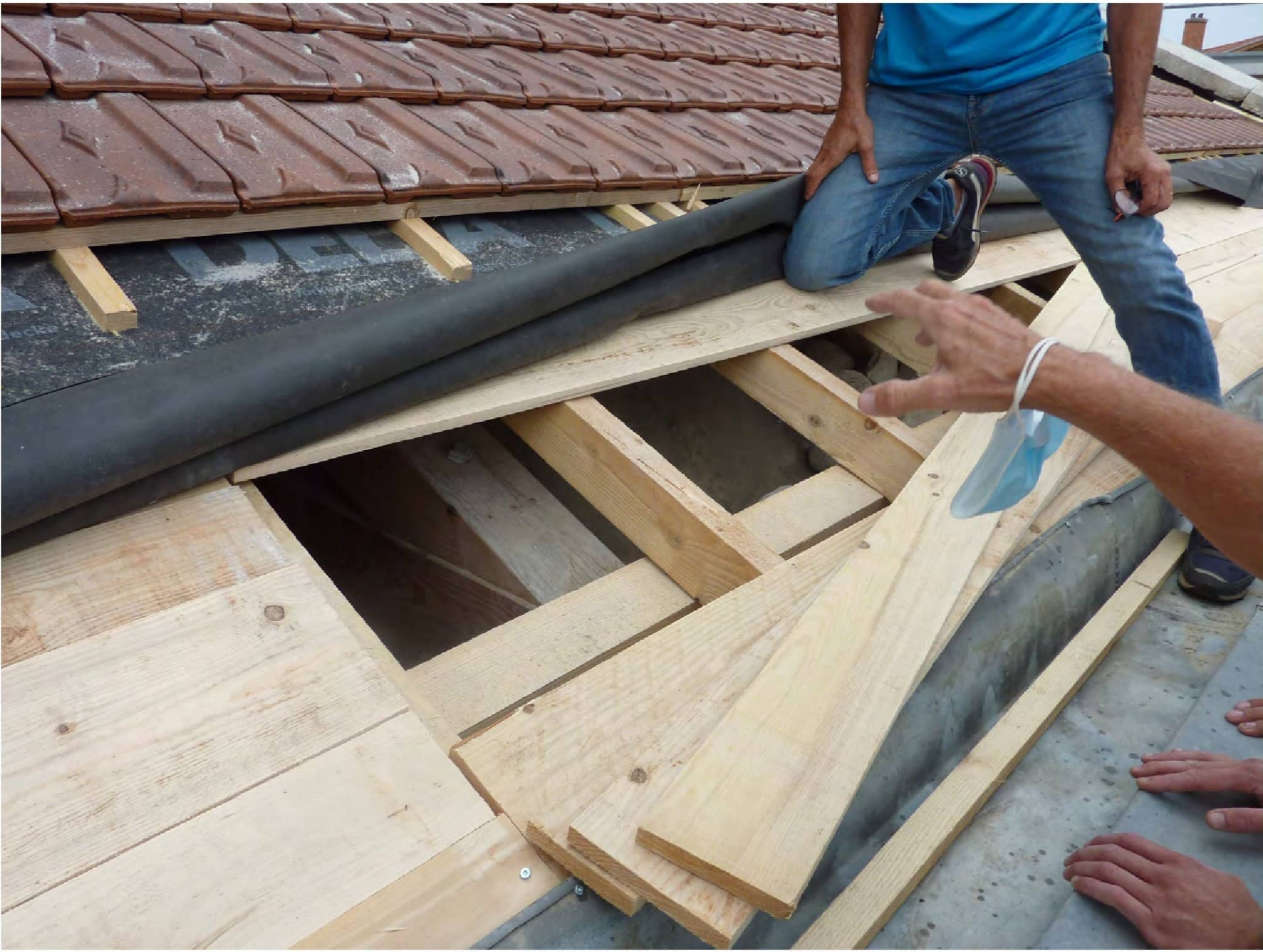
Il a été ensuite réalisé un complexe neuf comprenant : des chevrons en bois de sapin, une volige en sapin, un film de sous-toiture, des liteaux en sapin, et enfin la couverture en tuiles.
