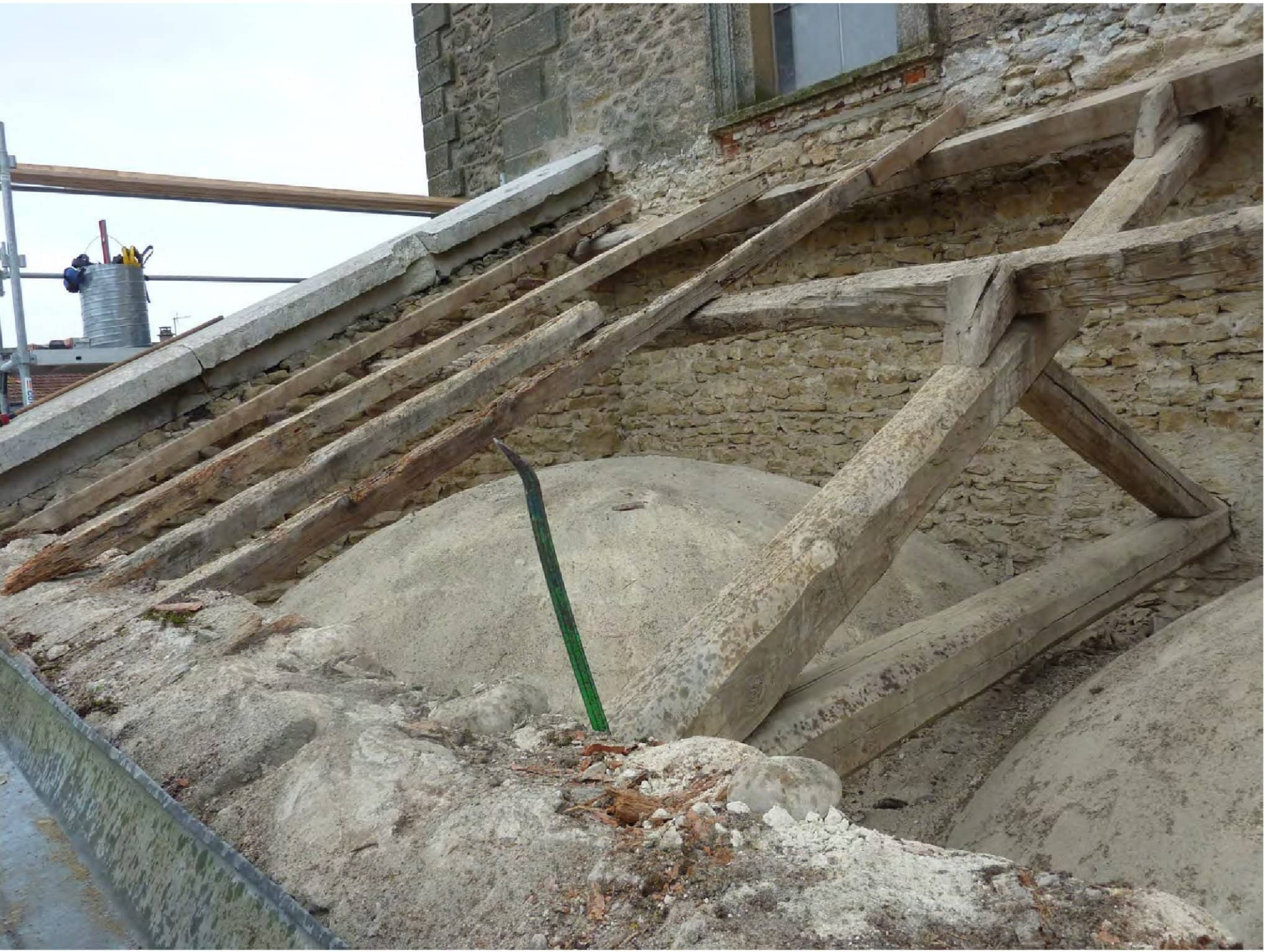
Les couvertures en place étaient vétuste et plus étanche. Elles ont été entièrement déposées, ainsi que les bois de charpente des bas-côtés les plus altérés en recherche.
