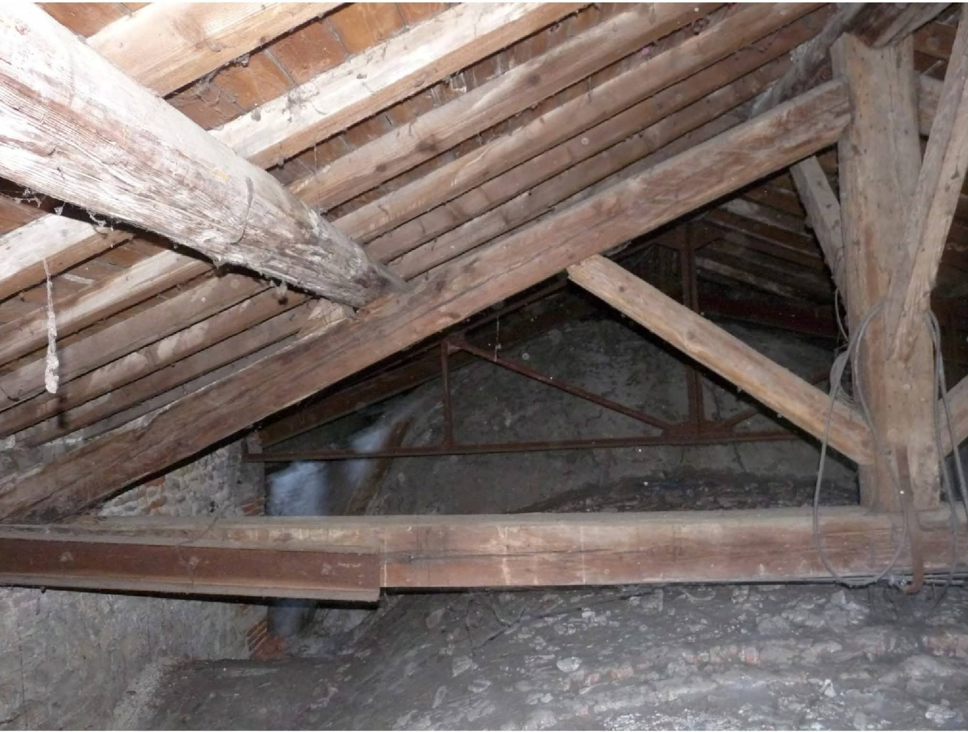
2019 : Des sondages sont organisés en toiture pour reconnaître l'état des charpentes. Au premier plan : ferme en bois d'origine, au second plan : ferme métallique de 1926.
