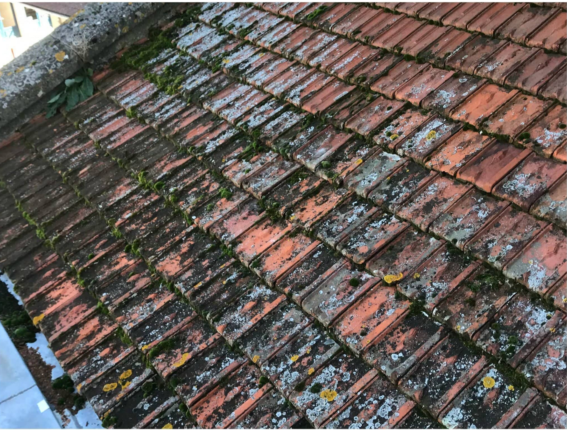
2019 : Une vue de détail, permettant d'apprécier l'état sanitaire courant des couvertures avant les travaux. Les tuiles et la zinguerie sont jugées entièrement vétustes.
