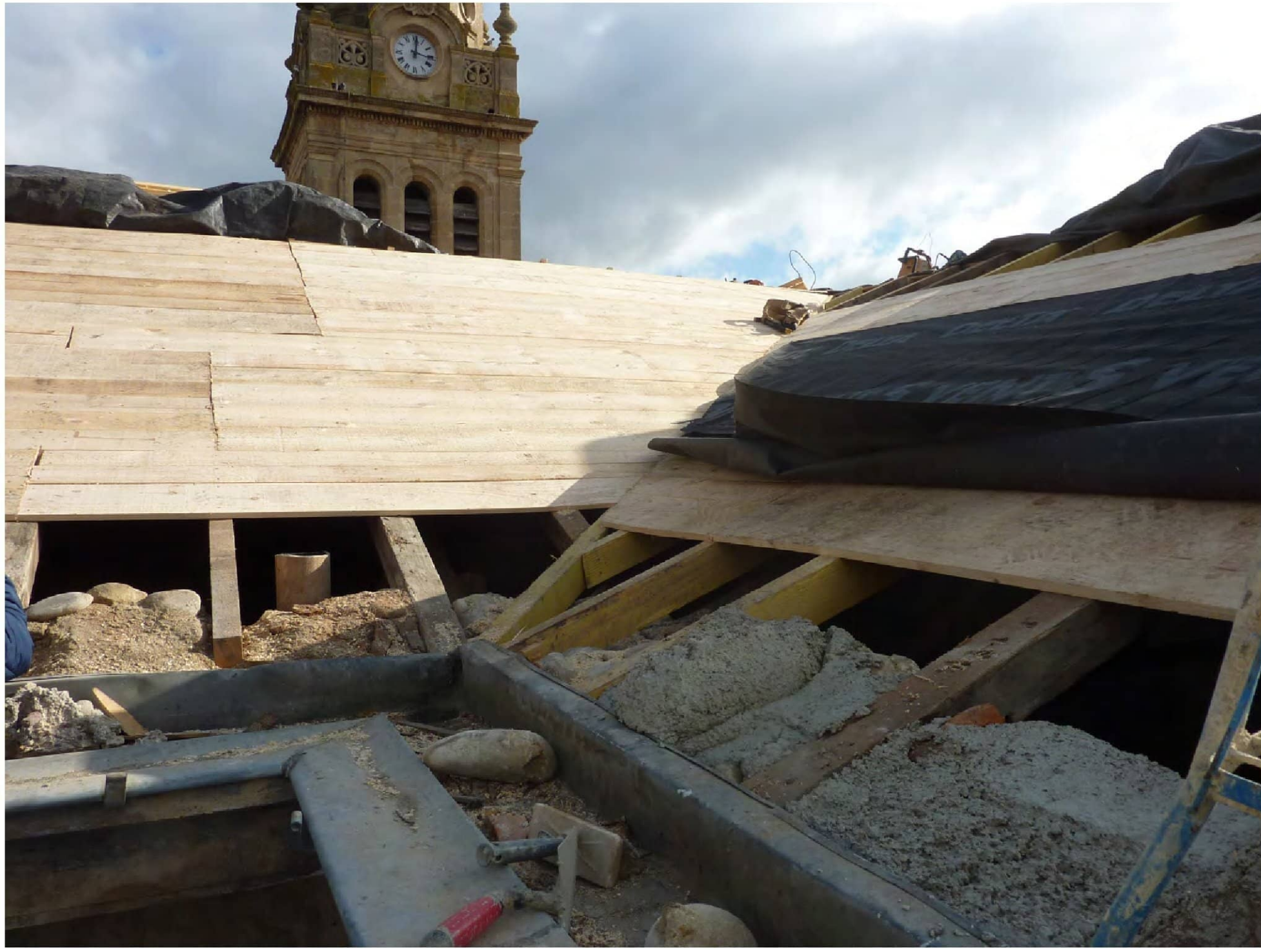
Restauration en cours de la couverture de la nef. On distingue, par la différence de teinte, les pièces de charpente remplacées sous la nouvelle volige en cours de mise en oeuvre.
