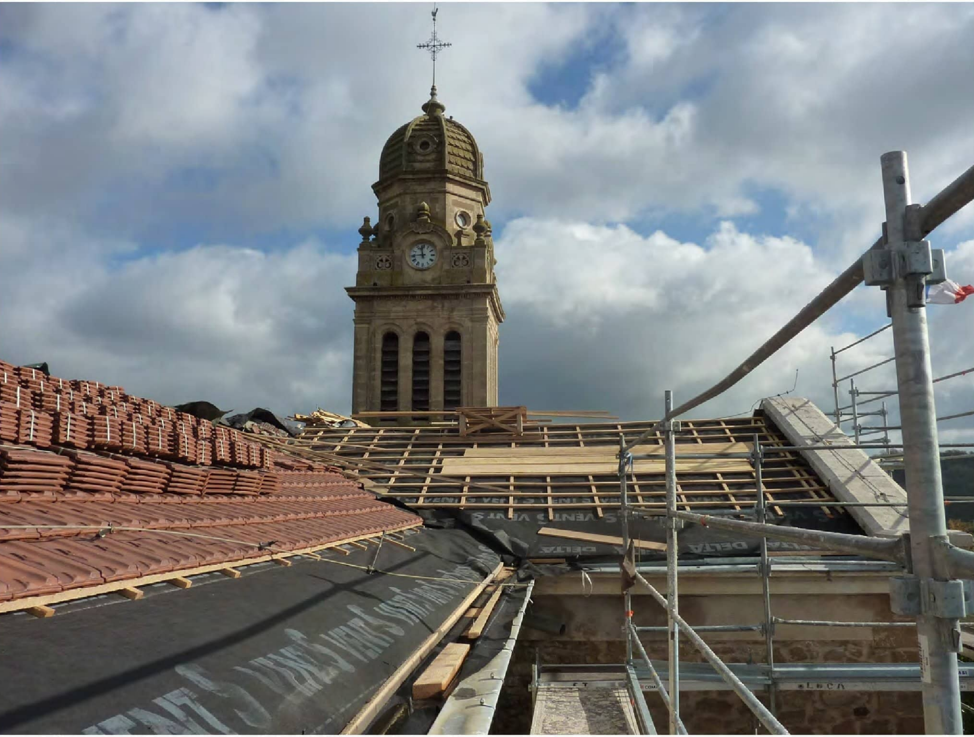
Le pose des tuiles losangées traditionnelles est en cours, avec une fixation au pureau sur liteaux. On part toujours du faîtage pour rejoindre l'égout de bas de pente.
