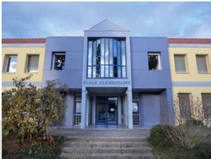
La partie carrelée de la façade n'était plus étanche, entraînant des infiltrations récurrentes. Elle a ainsi été remplacée par un bardage en panneaux composites.
