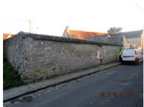
1 - Emplacement parking avant travaux
