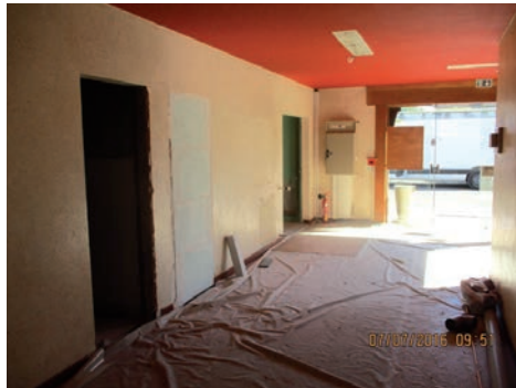
1 - Couloir entrée avant travaux
