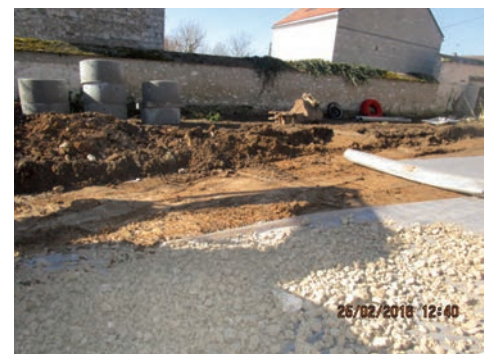
4 - Préparation support enrobé
