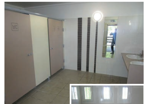
6 - Sanitaires après travaux
