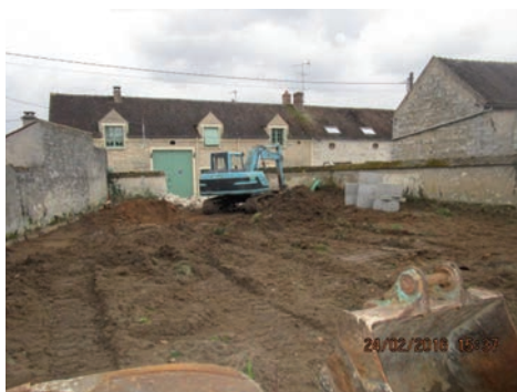
3 - Terrassement intérieur parking
