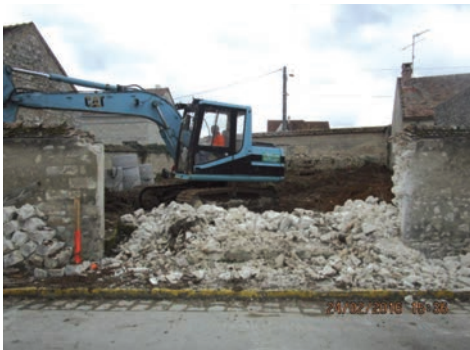
2 - Ouverture accès Février 2016
