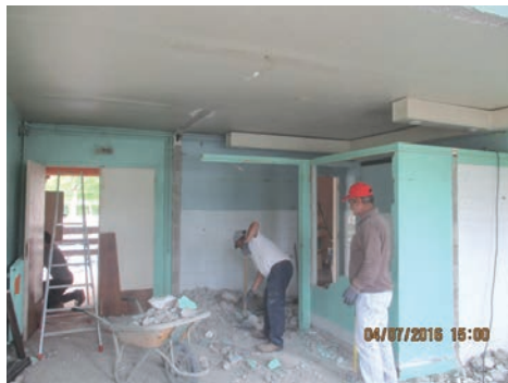
5 - Sanitaires en travaux
