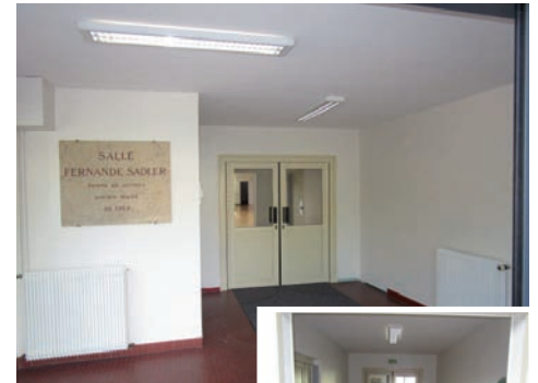
2 - Couloir entrée après travaux
